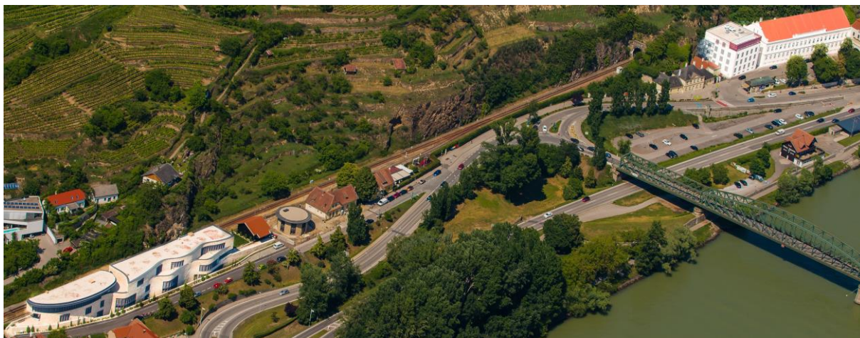
Abbildung 7: Der Altbau der DPU befindet sich samt Zahnambulatorium rechts oben im Bild. Der Neubau befindet sich links unten. Neben dem Neubau befindet sich eine denkmalgeschützte ehemalige Lagerhütte des Bahnhofes Stein, daneben ist der Lehr- und Forschungspavillon der DPU zu erkennen. Neben dem Pavillon befinden sich im ehemaligen Bahnhof Stein weitere Lehrräume. Den Bahnhof und das Nachbarhaus trennen zwei große Bäume. Im Nachbarhaus, das umgebaut worden ist, befinden sich nun Lehr- und Büroräume. Ein Drittel dieses baulichen Anteils ist im Berichtszeitraum renoviert worden.
